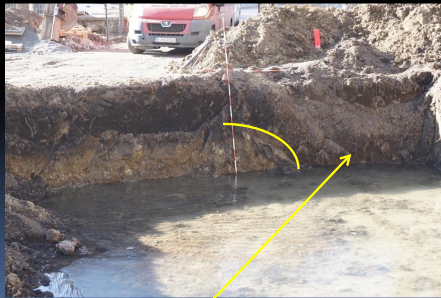
Vonkajšia priekopa, jej V okraj v profile výkopu
